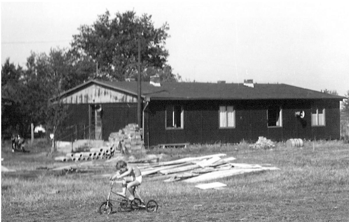
Letištní ubytovna s pomalu vršícím se materiálem; Nový Dvůr, srpen 1960
